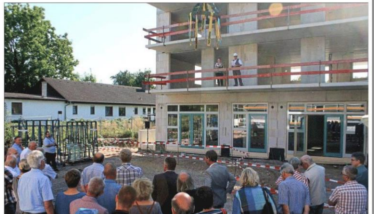
LOBENDE WORTE gab es von allen Seiten beim Richtfest für das Millionenprojekt. Im November 2018 war der Spatenstich, im Frühjahr 2020 sollen die Gebäude fertiggestellt sein. Foto: Müller
