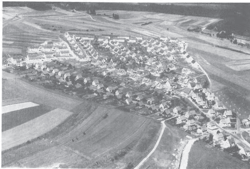
Zum Leistungsbild des ersten Jahrzehnts nach Gründung der Genossenschaften gehörten in allen Kreisen Badens zahlreiche geschlossene Siedlungen mit Einfamilienhäusern, die in rascher Folge in einem beispielhaften Schulterschuß mit Städten, Gemeinden und kirchlichen Stellen errichtet werden konnten. Fotos: Siedlung Degenfelder Straße in Rheinfelden (oben) und Schluch-Siedlung in Donaueschingen (unten).
