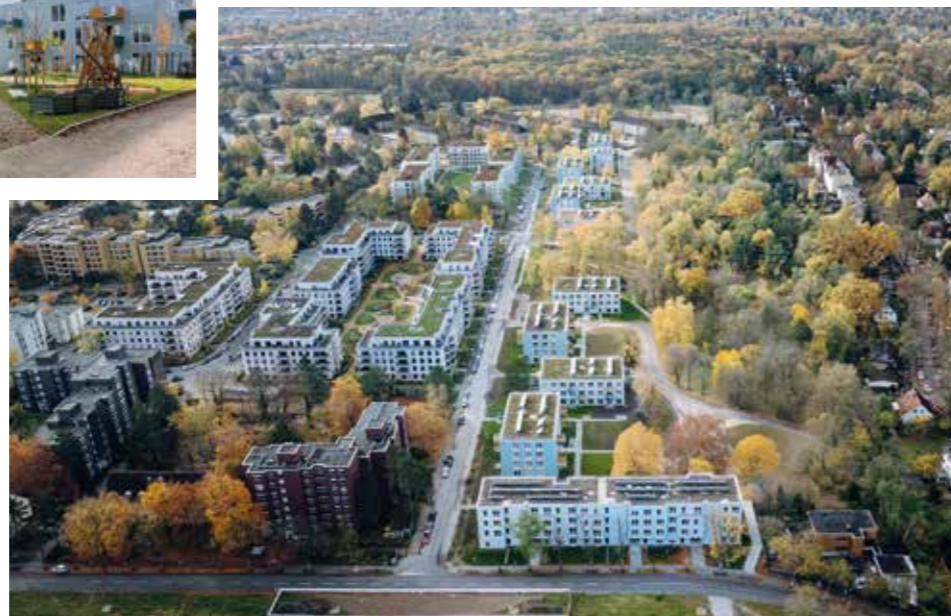
Wohngebäude in modularer Bauweise: industriell gefertigt, nachhaltig umgesetzt und flexibel nutzbar.
